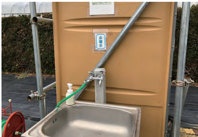
GAPに基づく表示方法の例:水栓に水道水と明記し地下水ではないことを表示している
